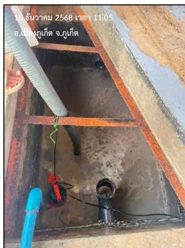
รูปภาพที่ 2.23 การสูบน้ำตะกอน
