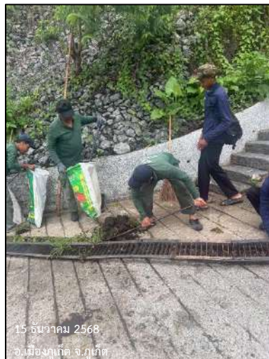
รูปภาพที่ 2.22 การขุดลอกตะกอน
