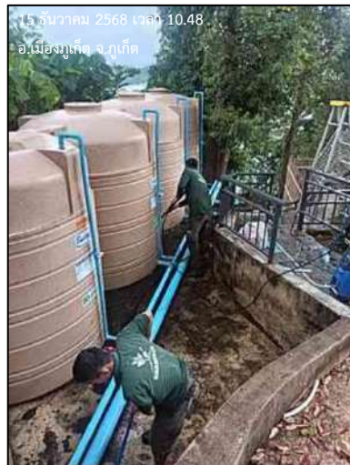
รูปภาพที่ 2.21 การตรวจสอบเส้นท่อ และสุขภัณฑ์
